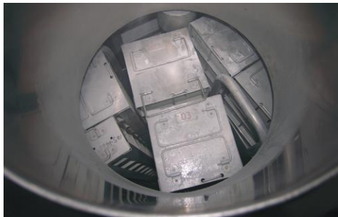
Fot. 7. Wnętrze zbiornika kriogenicznego – widok z góry (U. Wasileńczyk).
