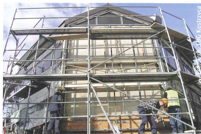
Ocieplenie wełną mineralną ściany budynku administracyjnego LBG Kostrzyca pod szklaną fasadą elewacyjną
