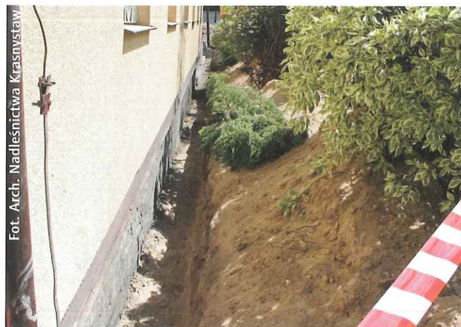
Docieplanie fundamentów biurowca Nadleśnictwa Krasnymstaw
